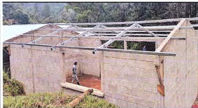
Foto 3: Aula 1. Cambio de estructura de techo de madera por metal.
