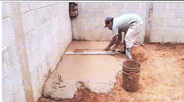
Foto 2: Imagen de aula No. 1. Fundición de piso de concreto.
