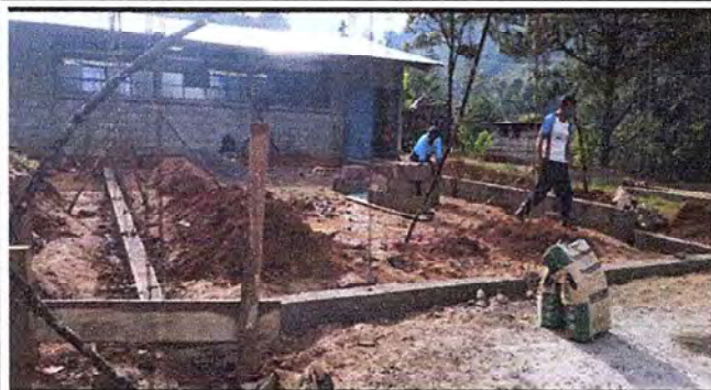
Foto 1: Imagen del aula No. 1. Habitación de pared de block y rectificación de columnas.
