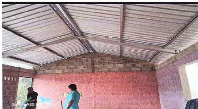
Foto 4: Aula 2. Cambio estructura de techo de madera y cambio de láminas en mal estado.
